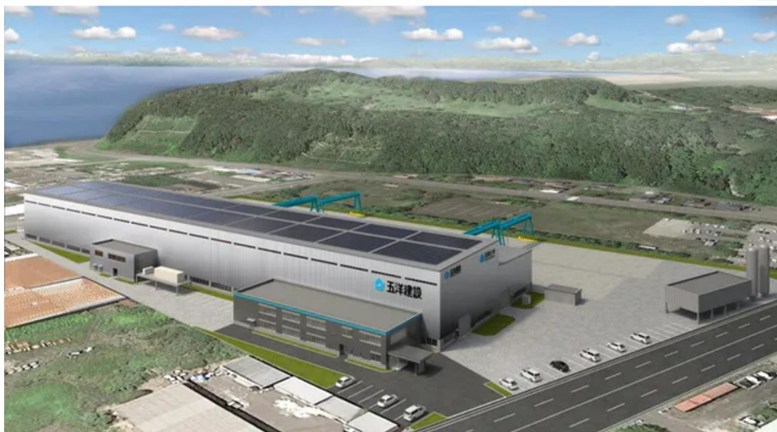
新工場では水素などを積極活用する（室蘭製作所、新工場のイメージ）
