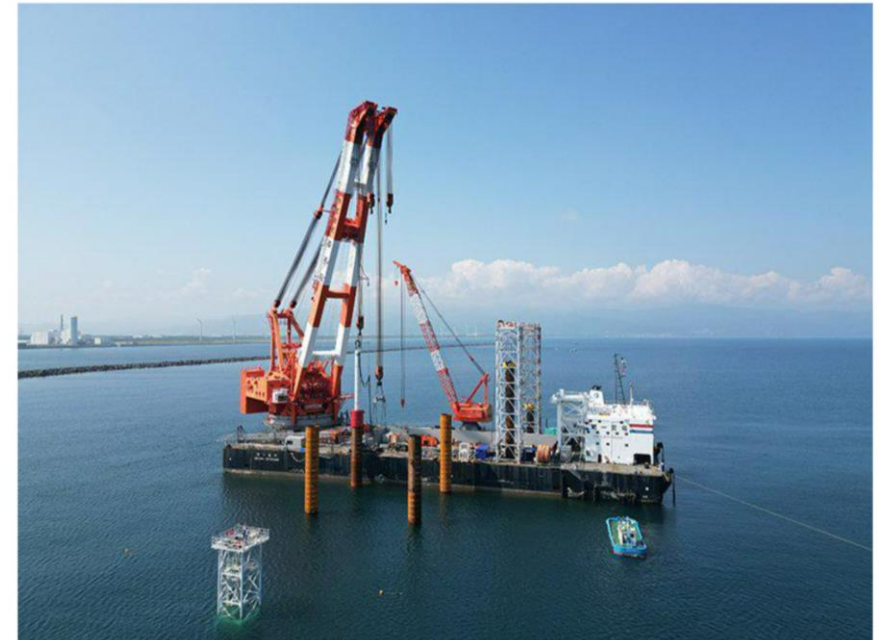
【石狩湾新港／現地海域での鋼管杭打設状況】
